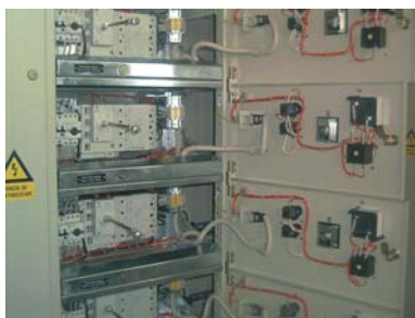
ProMotor T 3200 C Vedere zona aparate de comanda si comutatie
