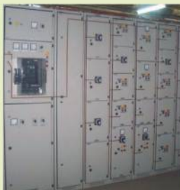
TDRI - constructie compartimentata
